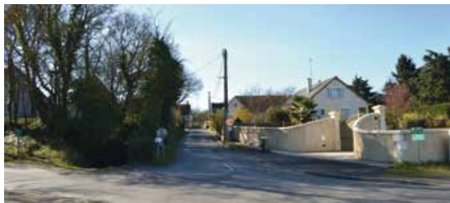
Assainissement rue du Petit Bois et impasse des Chesnaies
