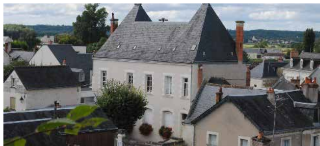
Travaux d'accessibilité en mairie
