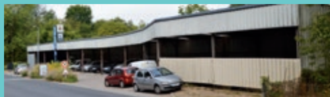
Avant, des hangars peu attrayants
