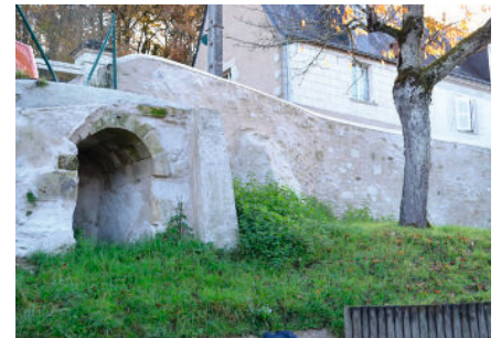
Puit et mur de soutènement de l'école - Patrimoine
