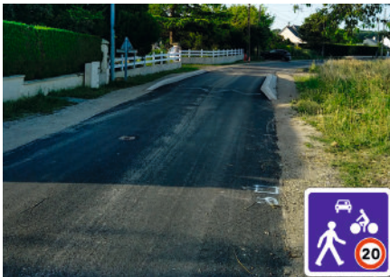
Route de la Fosse au Bray - Infrastructure
